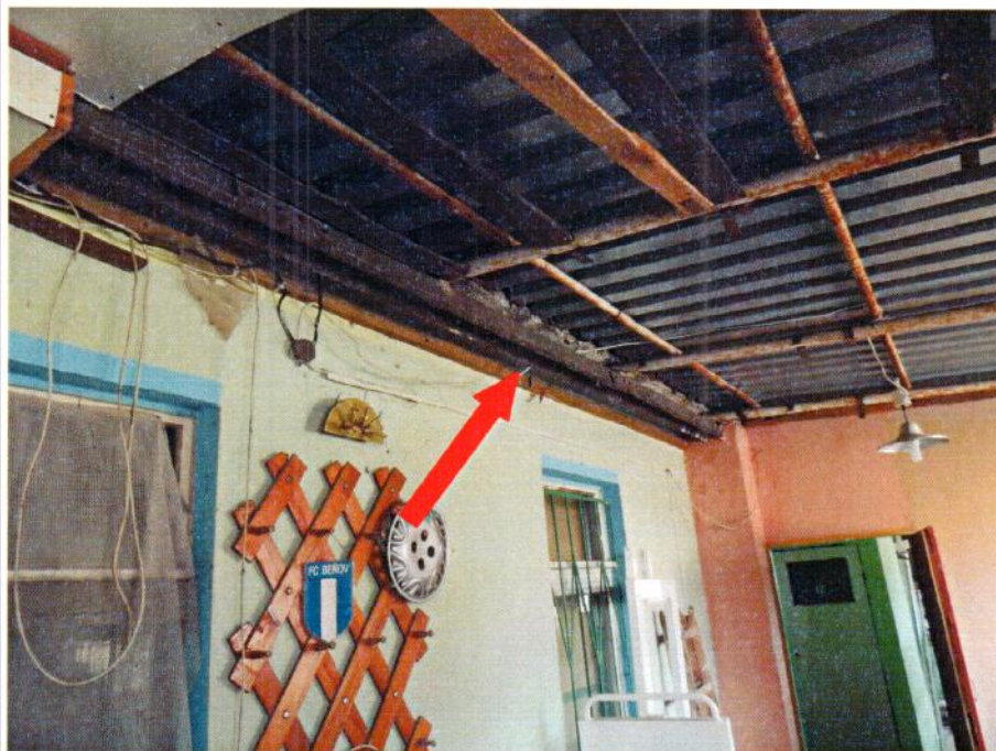
Zdjęcie nr 1. Odkryta część dachu, brak izolacji, widoczny układ belek wykonanych z rur okrągłych. Na zdjęciu zaznaczony kształtownik stalowy profilu V stosowany w górnictwie.
