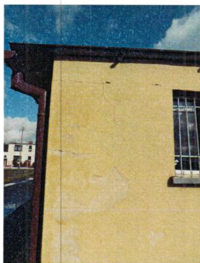
Zdjecie nr 7. Liczne pęknięcia ścian w narożnikach budynku. Na elewacji widoczne pęknięcia przebiegające od rur stalowych stanowiących konstrukcję dachu.
