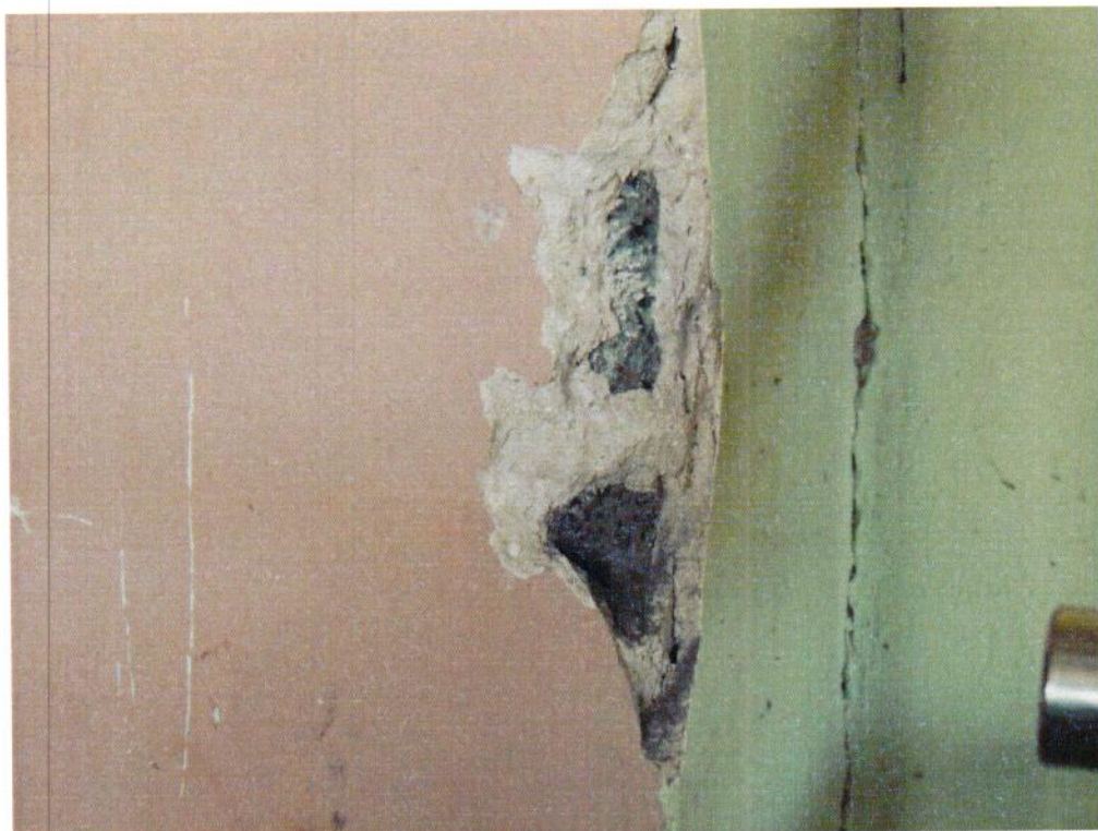
Zdjecie nr 3. Podczas wizji lokalnej oraz wykonywania odkrywek stwierdzono że istniejące pilastry wykonane są z bloczków żużlobetonowych. Pilastry nie są zespolone ze ścianą budynku.
