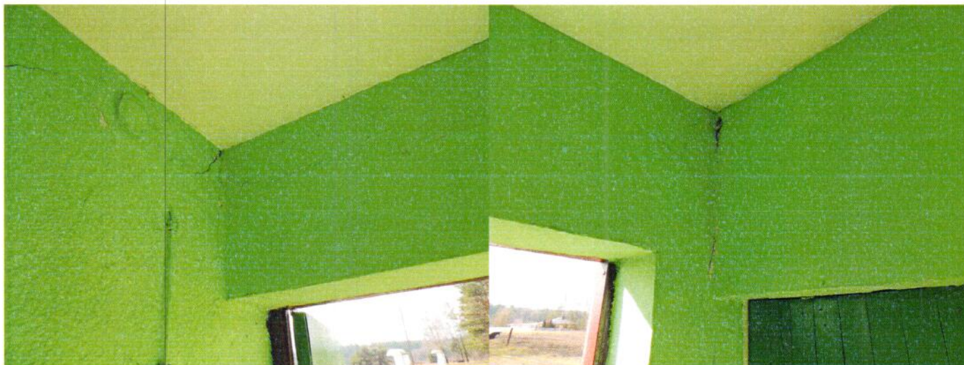
Zdjecie nr 5. Widoczne liczne pęknięcia w miejscu połączenia nadproży ze ścianą prostopadłą.
